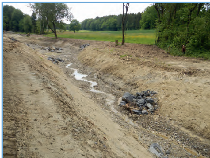
Début des travaux (novembre 2017) ©BEB
