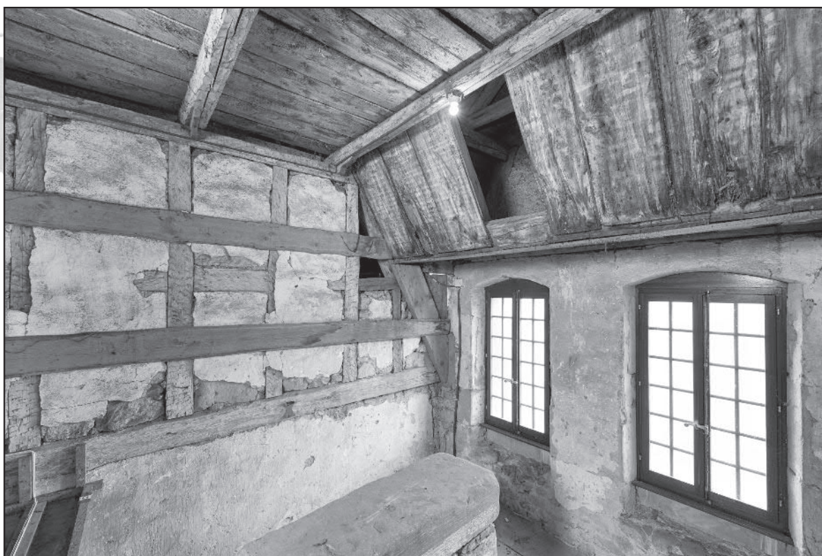
Mur à colombage et vieille charpente: des traces du passé dans les combles du château de Morrens. État de Vaud, documentation MAH-PBC, photo Rémy Gindroz
